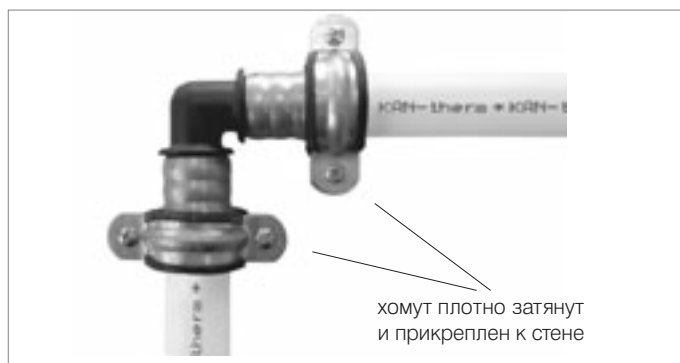
Выполнение точки неподвижной опоры рядом с отводом.
